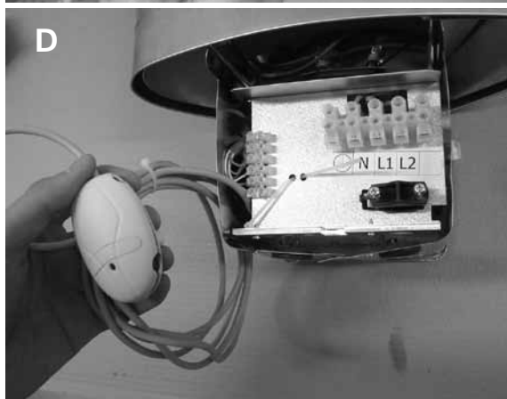
Kuva 8. Kytentäkotelon avaaminen Bild 8. Kopplingshöljets öppning
